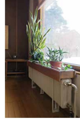
Aino ja Alvar Aallon talossa (Riihitie 20, 1936) patterien päälle sijoitetut kukkalatikat toimivat ilmankostuttajina.
