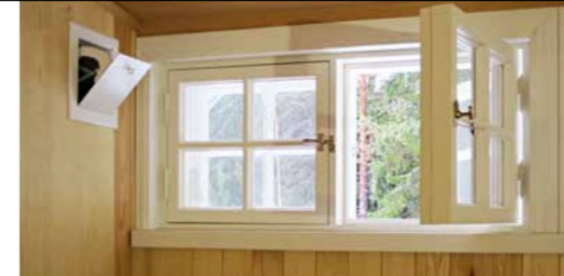
Säädettävyys kuuluu olennaisena osana painovoimaisen ilmavaihdon toimintaan.
