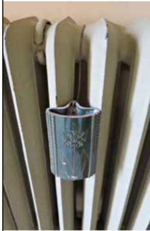
Lämmityspatterin sivulle ripustettu keraaminen ilmankostutin, joka saa käyttövoimansa keskuslämmityksestä.
