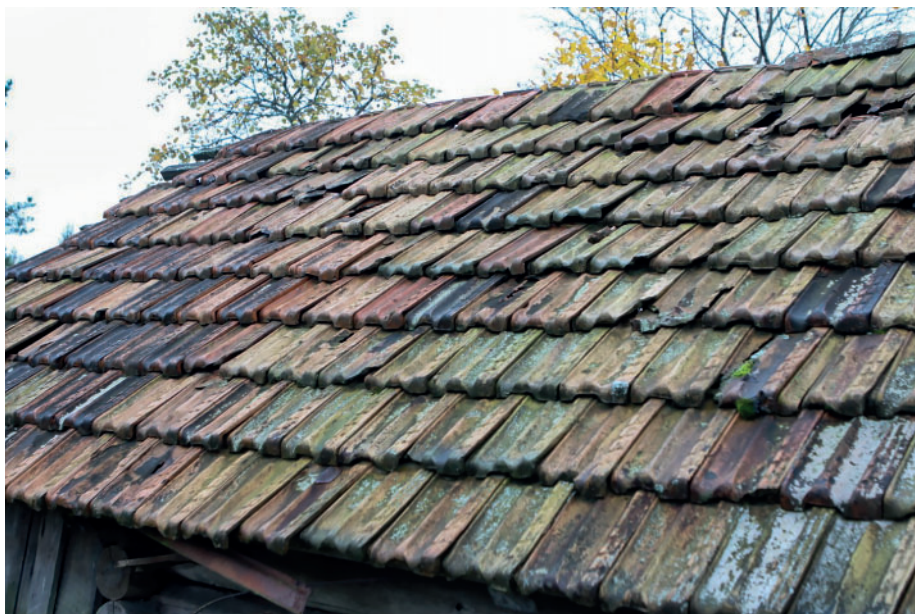
Jn 8. Vungi tööstuse katusekivid. Foto: Ahto Raudoja.
