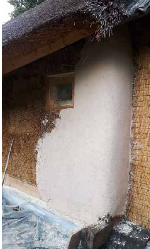
^ Termokrohvi paigaldus hoone põhupakkidest juurdeehitusele.
