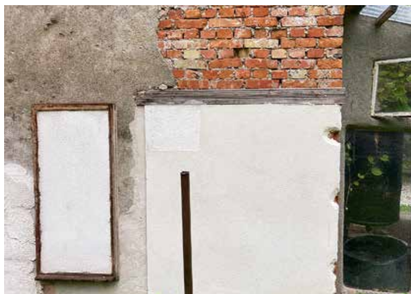
^ Ühe hooga seina visatud termokrohv, mis püsib tänaseni.
